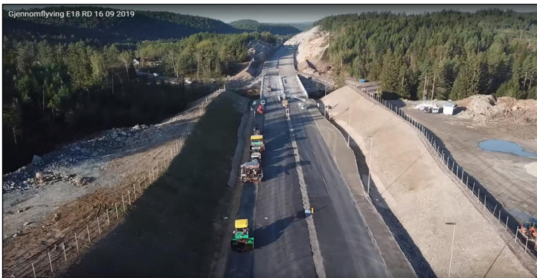
Figur 6-4: Fra arbeid med landskapsforming og støyvoller på ny E18 Rugtvedt - Dørdal.
