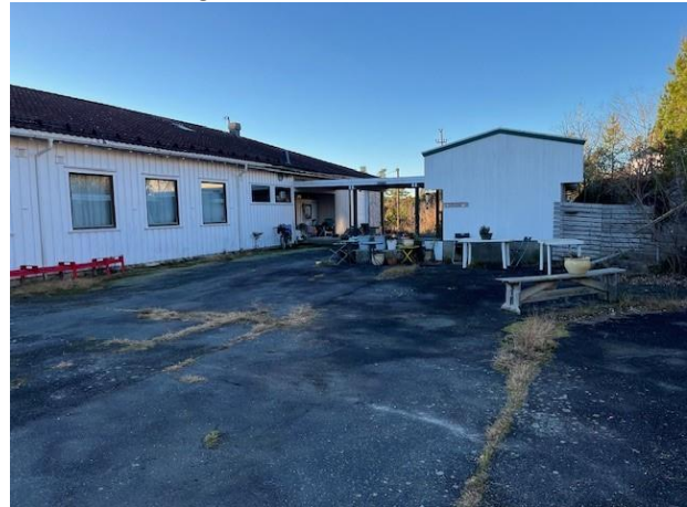
Skolebygningen og ta/tilbygg mot nord
