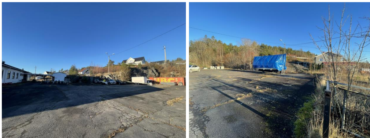
Foto viser byggeområde for nytt leilighetsbygg med tilhørende utomhusareal, sett fra sør.
