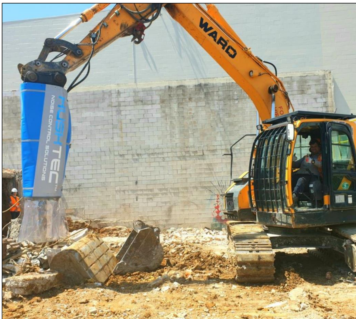
Figur 4-6: Bilde av støydempingskappe på pigghammer. Bildet er hentet fra Ankerløyken sine hjemmesider.
