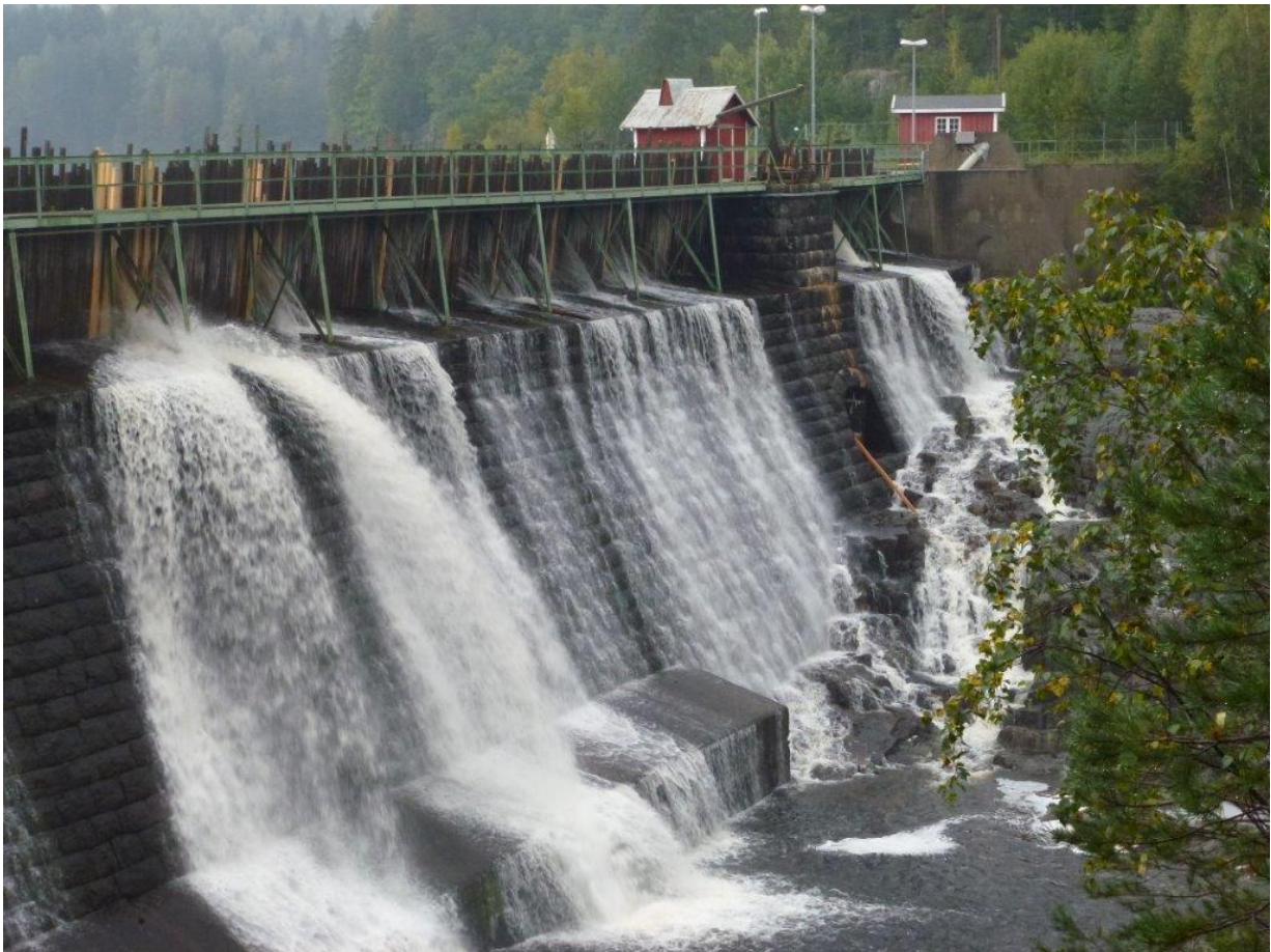
Dalsfoss dam i 2011 før ombyggingen, foto E. Karlsen
