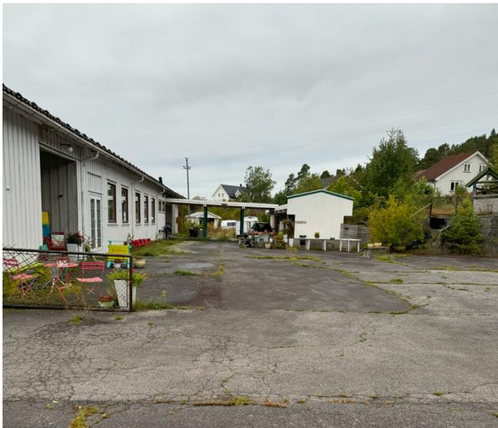
Bilde viser den gamle skolebygningen til venstre som er fundamentert ned på fjell. Til høyre på bilde stikker en naturlig fjellskjæring opp som danner den bakre delen av gårdsplassen. Området imellom bygning og fjell er fylt opp for etablering av skolegården.
