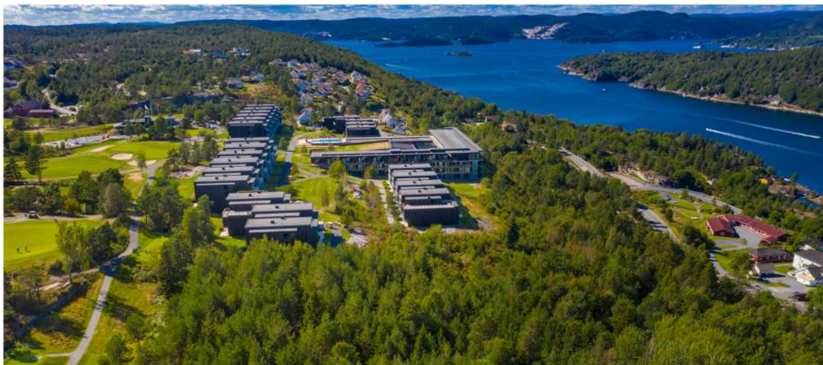
Figur 6-11. Bilde av dagens situasjon ved Kragerø Resort. Bilde tatt fra øst.
