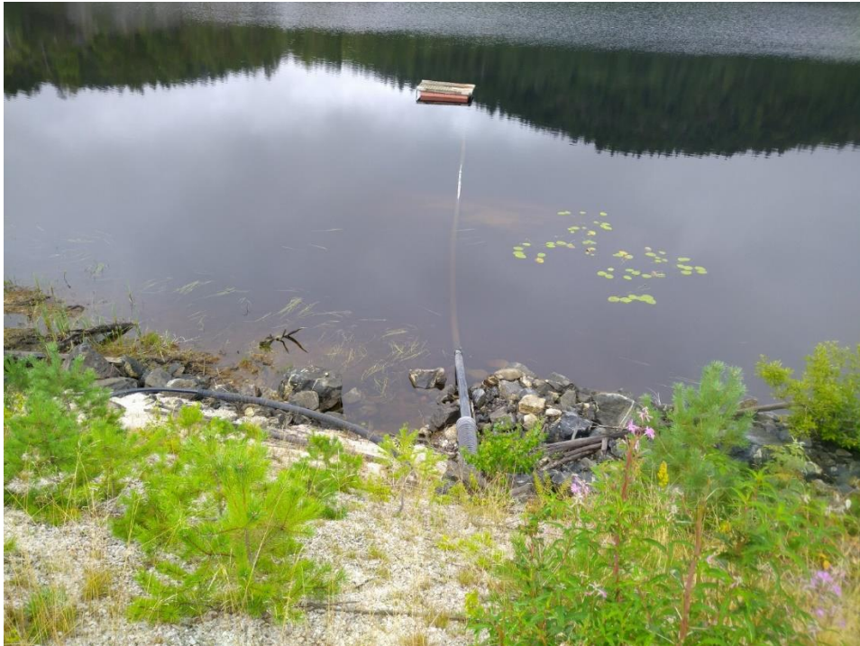
Inntaksrøret til kraftverket i Frøvikstjern.
