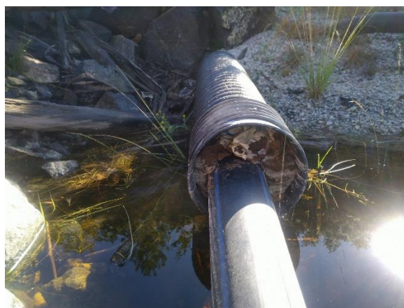
Bilde 3. Kraftverksrøret går i «rør i rør» under dammen og er ikke egnet for utvandring.
