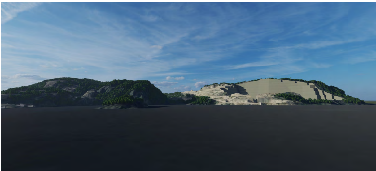
Figur 6-16 Etappe 1 – Den østlige siden av Holtebergheia åpnes opp for uttak. Bruddflatene vil reflektere hvitt lys på solskinnsdager. Omrisset av Holtebergheia er som før, og strandsonen bevares.
