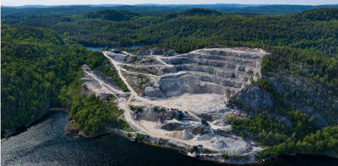
Figur 3-6 Dronefoto. Dagens situasjon sett fra nordøst.
