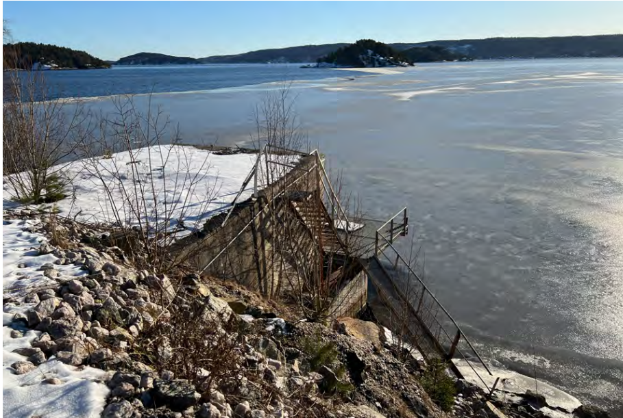
Figur 5-8. Eksisterende betongkai fra tidligere utskipping
