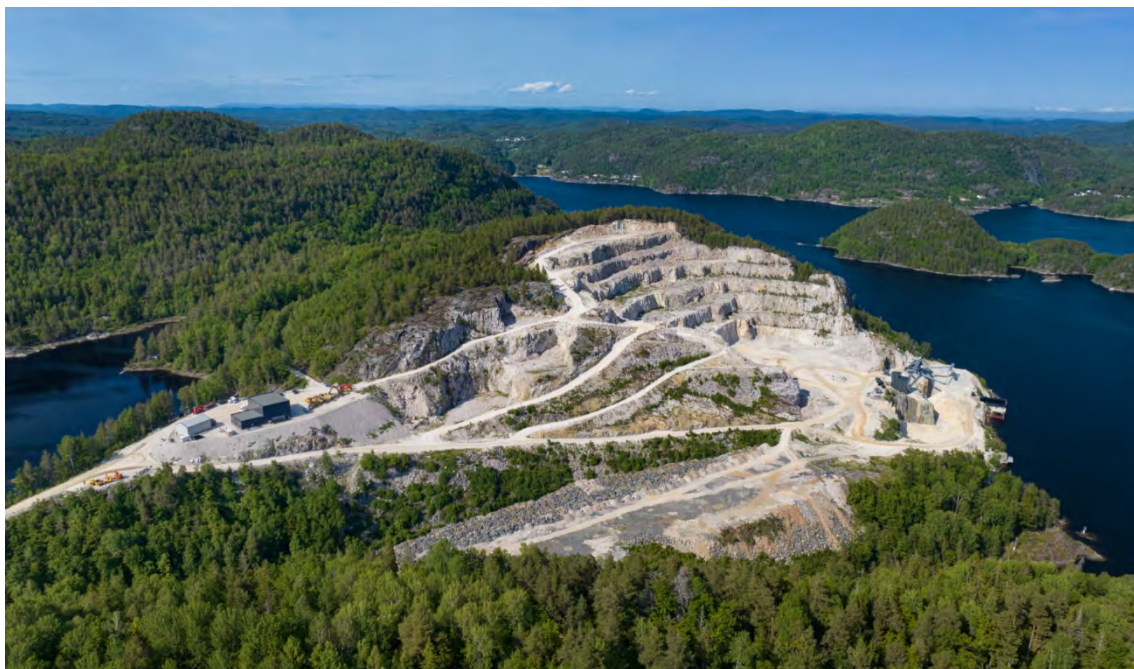
Figur 6-3. Oversiktsbilde/dronefoto. Dagens situasjon sett fra syd.
