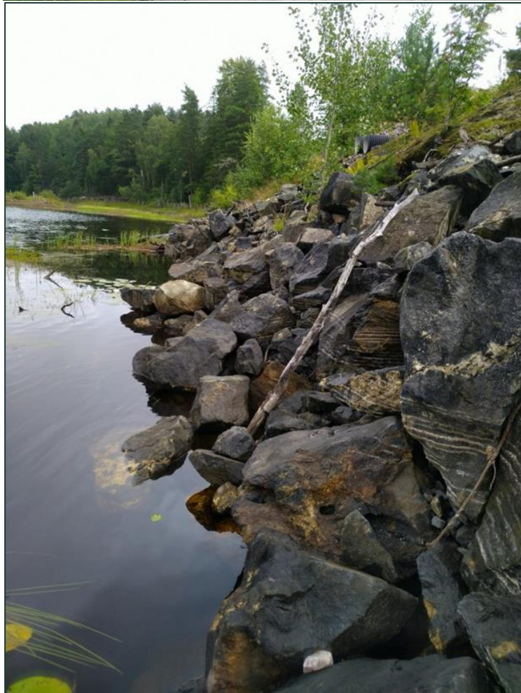
Figur 1-6. Bildet viser gammel isdam og ny veifylling ovenfor som også fungerer som reguleringsdam for Frøvikvann. Vi ser overløpsrøret øverst i fyllinga på det nedre bildet.
