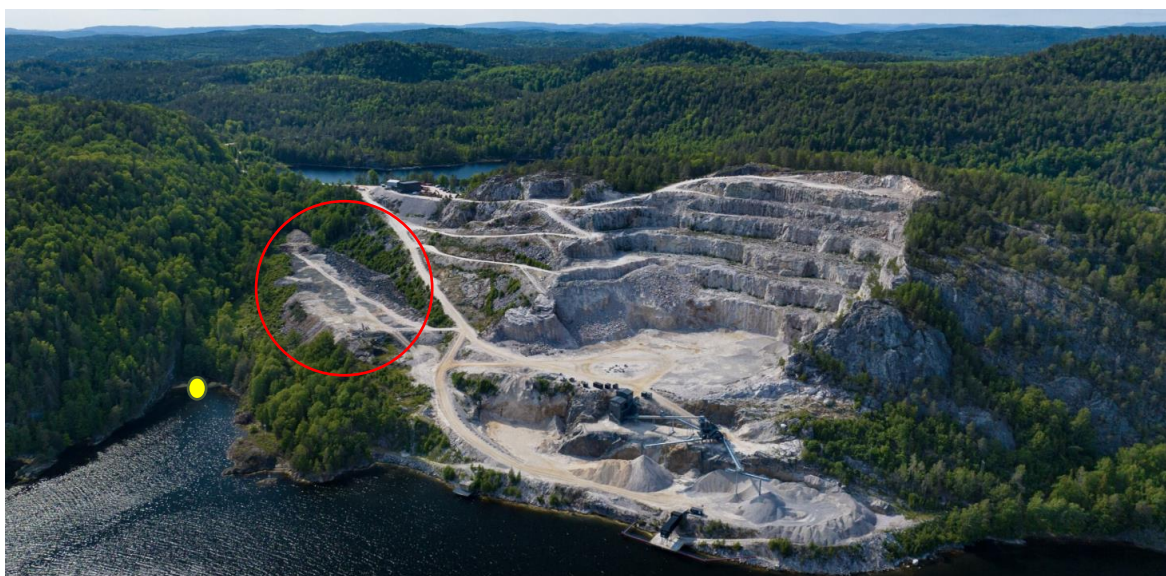
Figur 1-1. Dronefoto. Dagens situasjon sett fra nordøst. Skrotsteinfyllingen er markert med rød ring. Utløpet av Snekkevikbekken ligger innerst i vika til venstre i bildet, markert med gult punkt. Frøvikvann skimtes i bakgrunnen.
