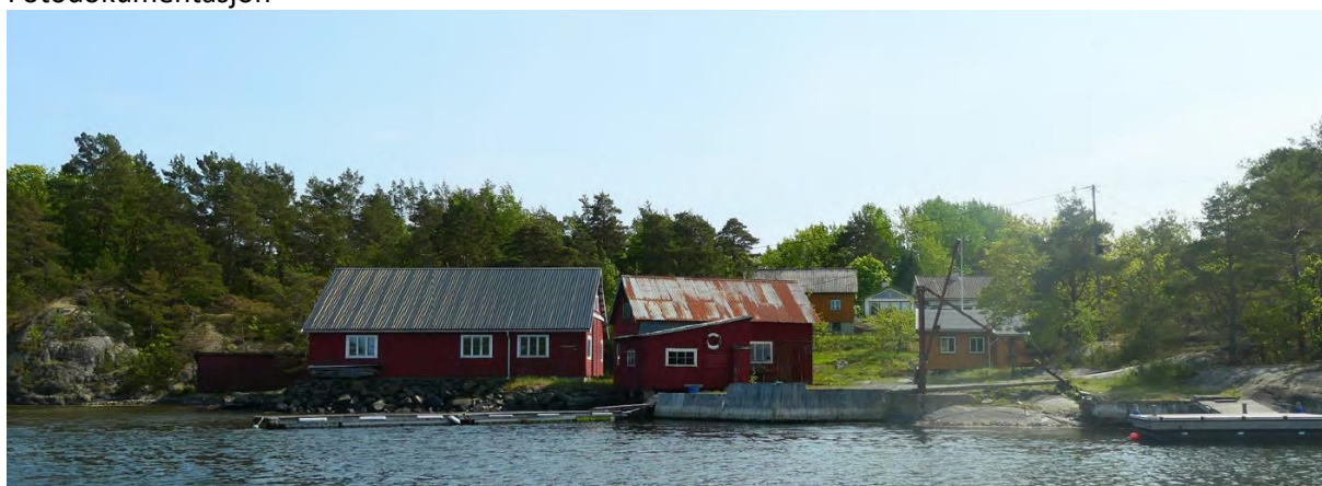
Figur 4: Dagens situasjon sett fra sjø. Verkstedbygninger som forfaller.
