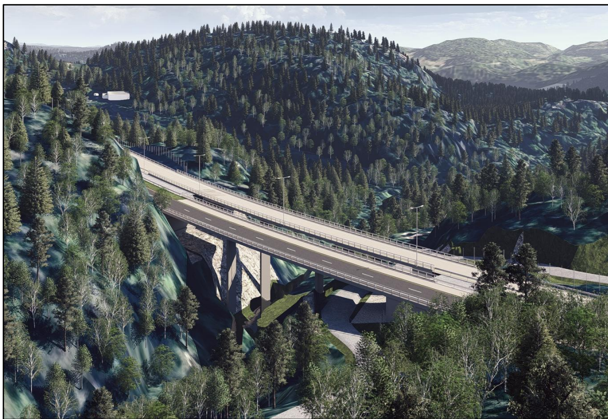
Figur 3-23: Illustrasjon av planlagt bru over Tyvannselva, sett fra nordøst. Dagens bru (lengst vekk i bildet) kan bli erstattet med ny bru for nordgående løp. Ny bru for sørgående løp nærmest i bildet. (Kilde: Sweco)
